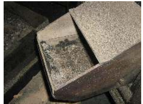
Проверете пепелния остатък върху скарата на горелката.
